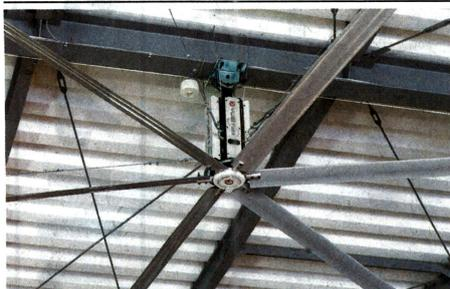
の羽根を省電力で回転させ、空間全体に気流を生み出すことで、快適空間と省エネ効果を実現する最新の空気攪拌設備。風量は、無段階調整機能で、季節や環境に応じて自在にコントロールできる。特長の1つが省エネ。シーリングファン1台で、約1500平方メートルのスペースをカバー可能。同じ面積をカバーするために必要な工業用扇風機と比べ、1年の電気代を約80%低減することができる。6枚の軽量アルミブレードがゆるやかに空気を循環し、サーキュレーション効果で冷暖房の効率を高めることができる。立体的に対流を起し、ムラのない効果的な空気循環を得られるのも特長だ。
